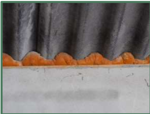
Gesloten ruimte tussen dak en muur
