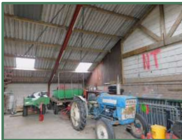
Binnenzijde te slopen varkensstal
