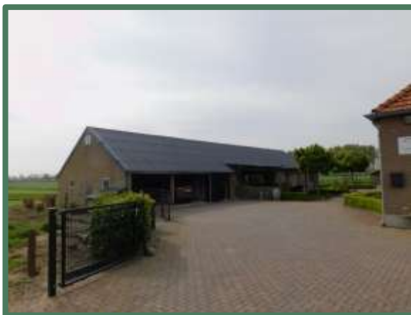
Loods in gebruik als garage
