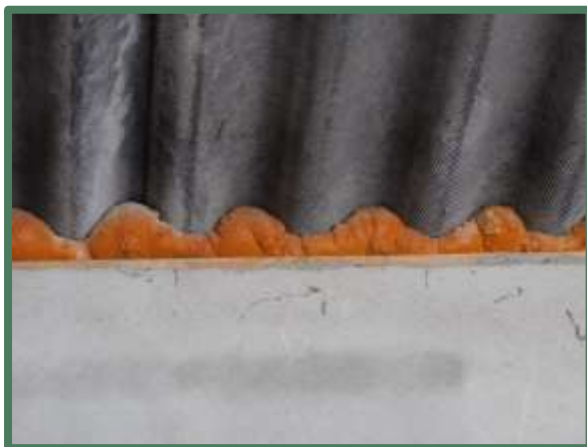
Gesloten ruimte tussen dak en muur
