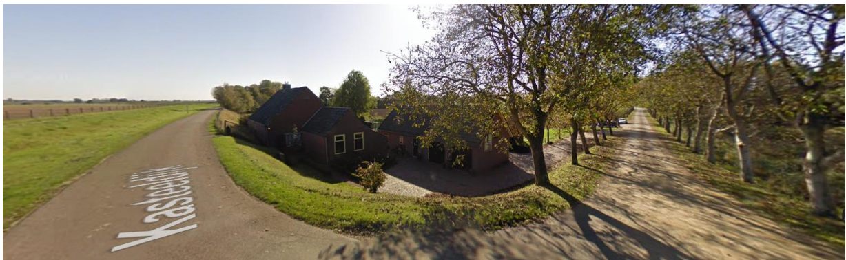
Figuur 12: hoek Oijense Bovendijk en Kasteelstraat, met 2 van de omliggende woningen
