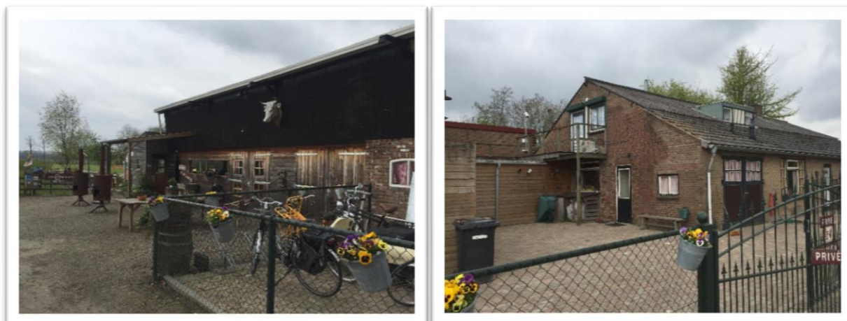
Figuren 1 en 2: Overzichtsfoto's onderzoekslocatie.
