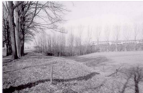
Foto 3.3.2s Het Kasteelse Bolwerk was voor het opmetselen in 1999 een uitstulping in de dijk
