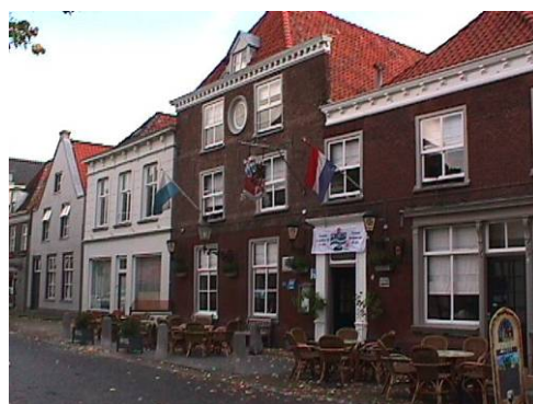
Foto 3.4b Lijstgevels en schuiframen in de Marktstraat
