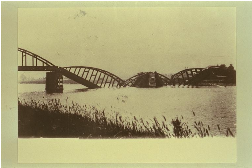
Foto 1.5b De verwoeste spoorbrug over de Maas
