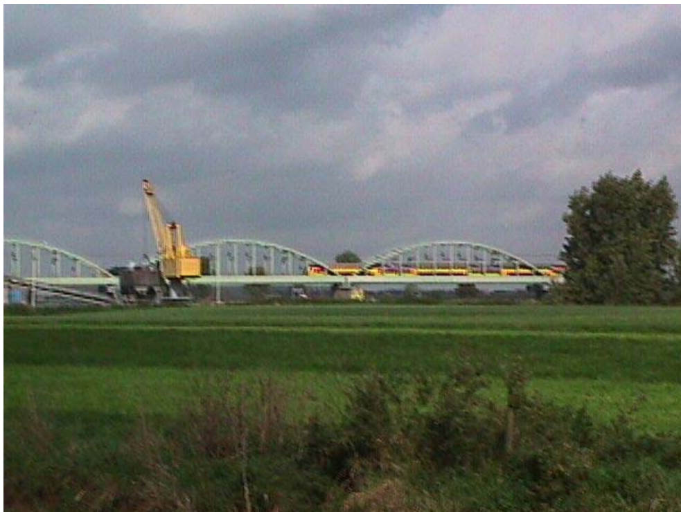
Foto 1.5c De huidige spoorbrug over de Maas bij Ravenstein
