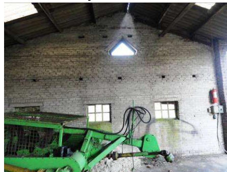
Detail binnenzijde werkloods: spouwmuur met grote openingen aan zowel binnen als buitenzijde.
