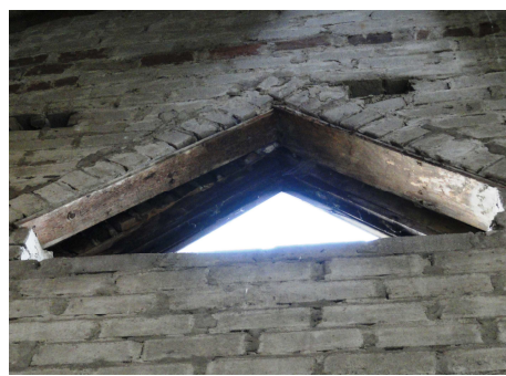
Detail raamkozijn met aan binnenzijde toegang spouwmuur aan bovenzijde kozijn.
