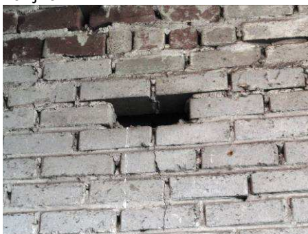
Detail opening in spouwmuur met sporen van gebruik door een vogel
