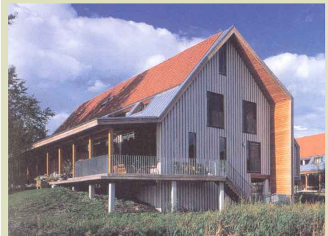
schuurachtige bouwmassa met veranda geïntegreerd in de bouwmassa
