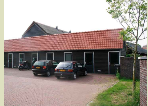
één gezamenlijk bijgebouw, ondergeschikt aan hoofdbouw
