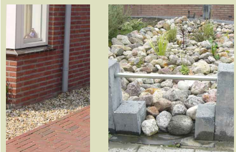
zichtbaar infiltreren van regenwater op eigen terrein
