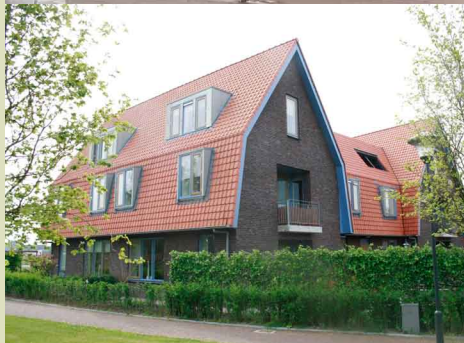
woningen met flinke kappen en dakramen/-kapellen
