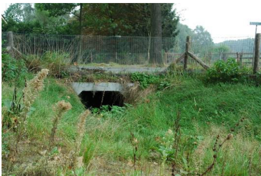
Figuur 5.3 Kleine faunatunnels in de N395 ter hoogte van Middelbeers en de N284 bij Bladel.
