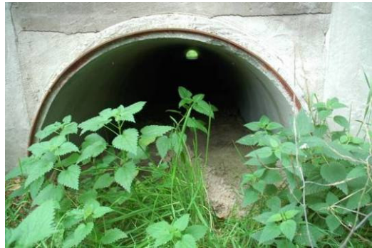
Figuur 5.3 Kleine faunatunnels in de N395 ter hoogte van Middelbeers en de N284 bij Bladel.
