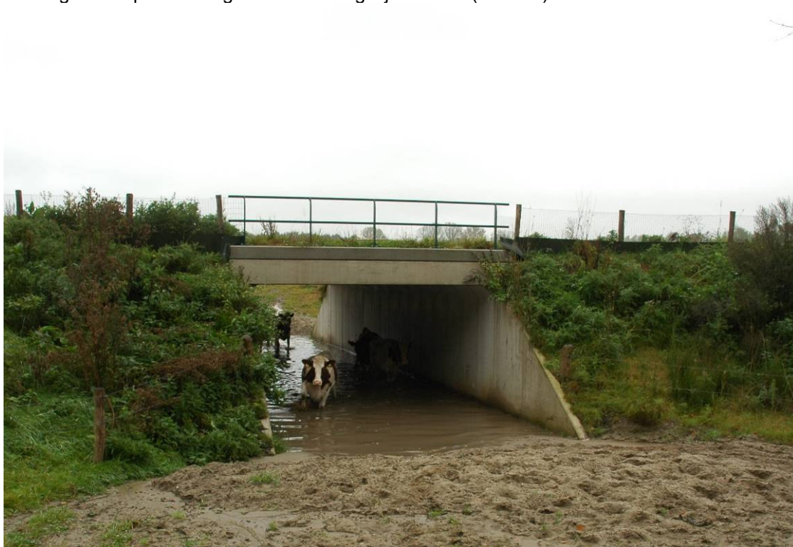
Figuur 5.4: Voorbeeld van een grote faunatunnel (Oude Grindweg, Oirschot) waarbij regenwater niet voldoende wordt afgevoerd.
