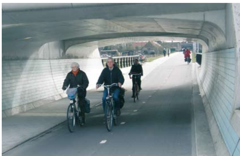
Veilige tunnel (Hasselterweg).
