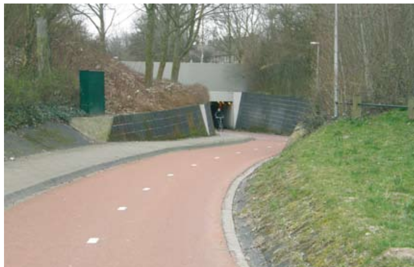
Onveilige tunnel (Ittersum Allee Tunnel).
