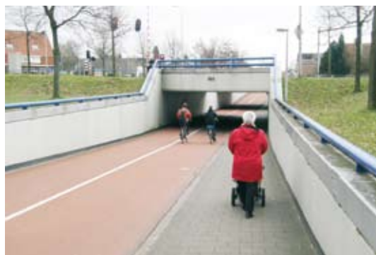
Voetpad naast het fietspad.
