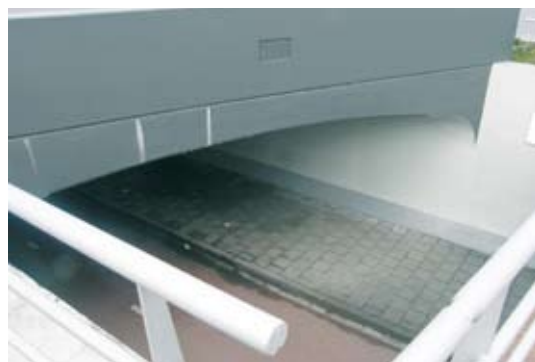
Optisch korte tunnel door middenberm niet te overkappen.
