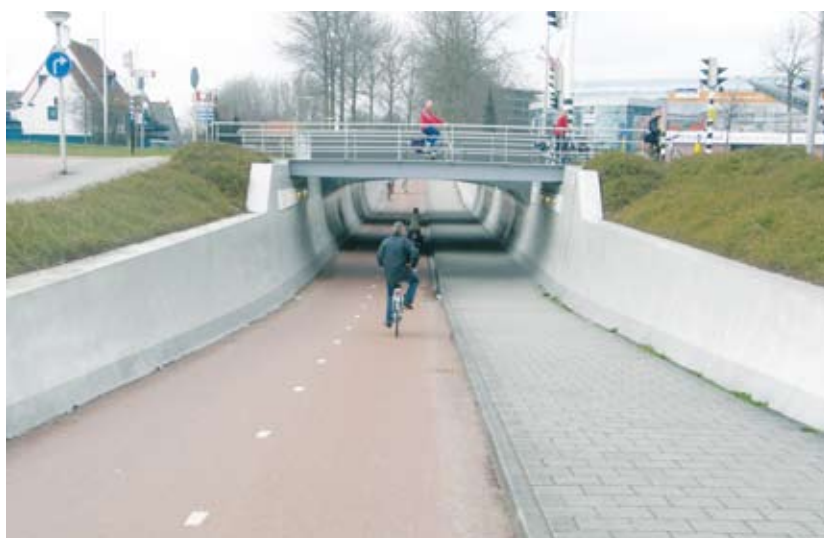
Veilige tunnel (Zwarte Water Allee).
