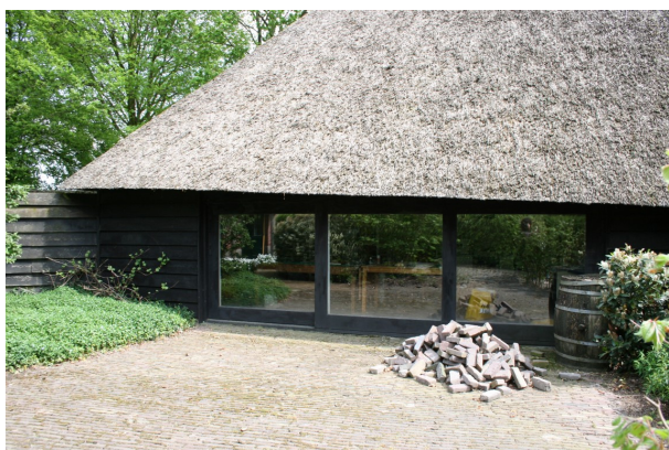
Glaspui in de langsgevel van het nieuwere gedeelte
