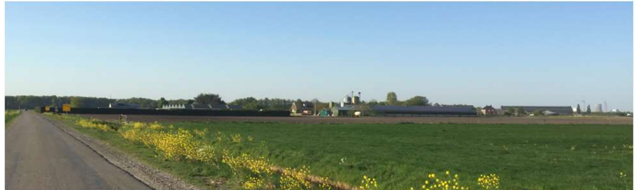
1)Komend uit het zuiden; de zuid- en zuidwestzijde toont zich aan de passanten
