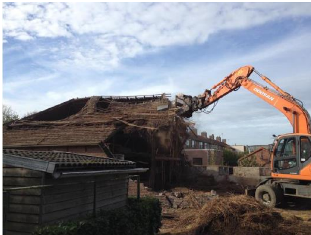
Figuur 2-1: Sloopwerkzaamheden van de schuur.
