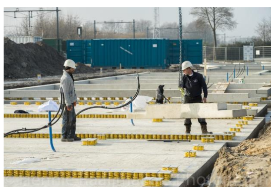
Figuur 4.2 Voorbeeld van stalen veren in het project Lavas Prinsenbeek (woningen naast het spoor)
