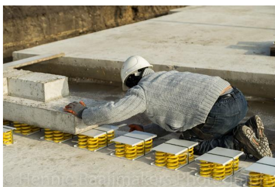
Figuur 4.2 Voorbeeld van stalen veren in het project Lavas Prinsenbeek (woningen naast het spoor)
