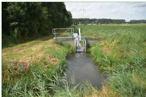
Sloot met dam.
