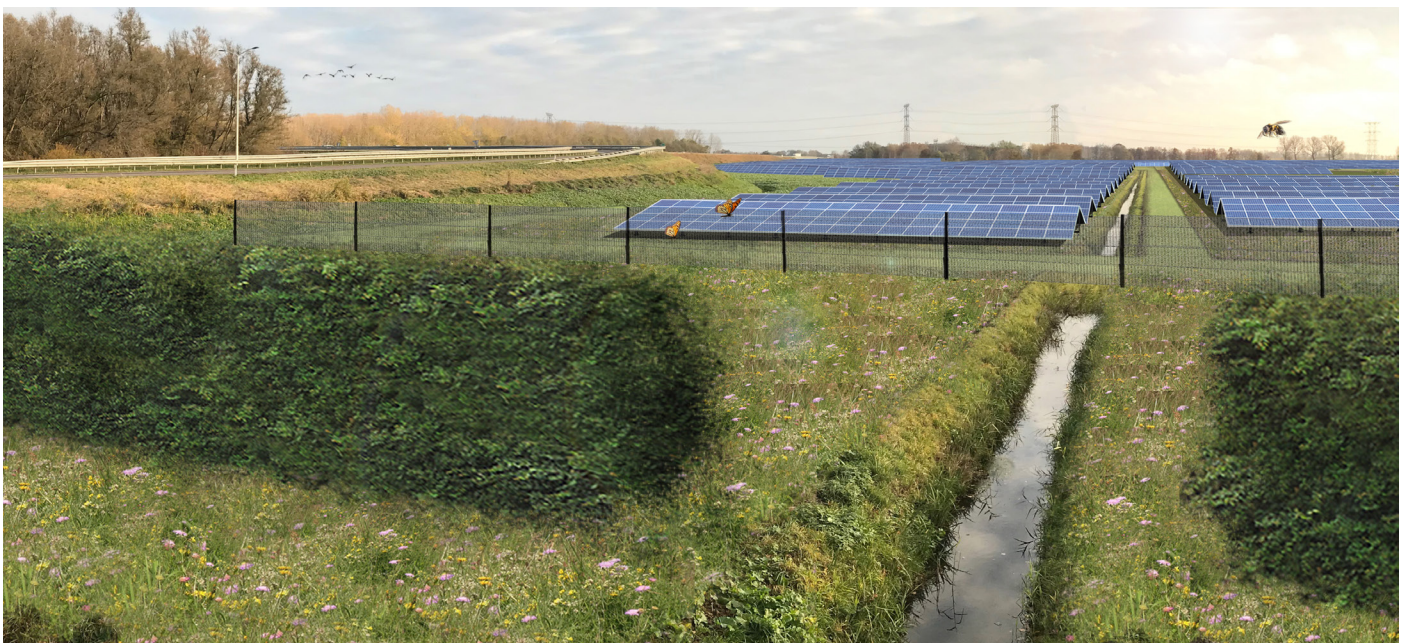
Zichtpunt V, Westzijde vanaf de Statendamweg
