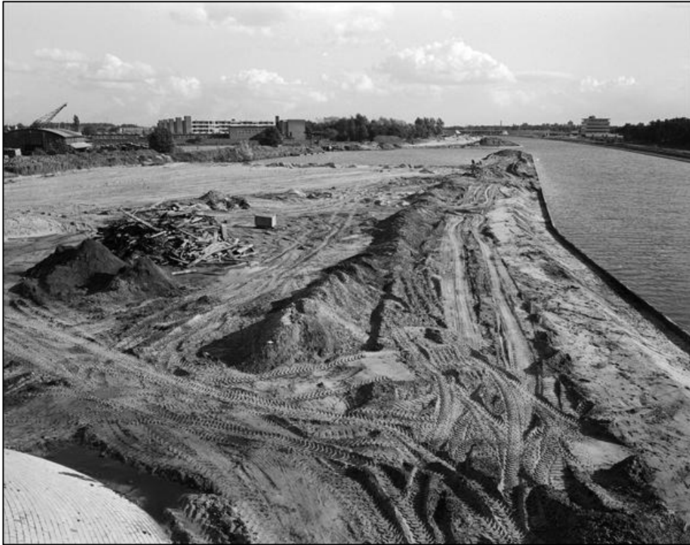
Afb. 9.- Foto van het onderzoeksgebied tijdens de aanleg van het nieuwe sluisencomplex d.d.1973 (bron: beeldbank Rijkswaterstaat).
