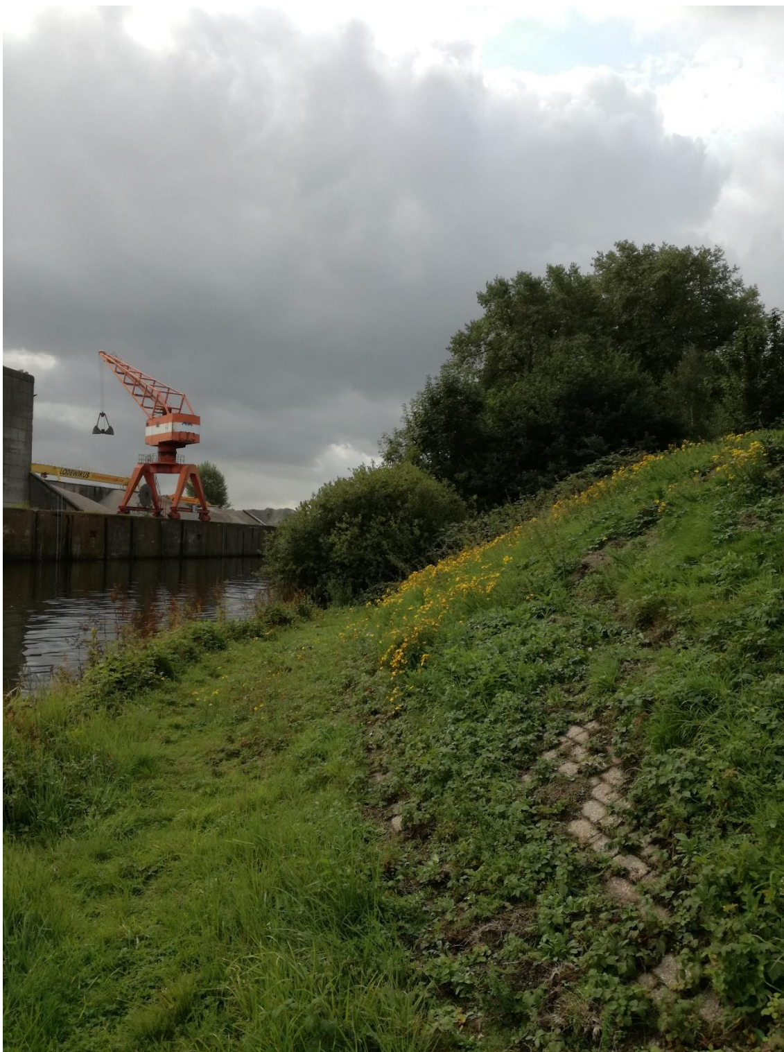
Figuur 3. De kop van het Eiland, kijkend in zuidelijke richting met het water van de Zwaaiikom en het bedrijventerrein aan de overzijde.
