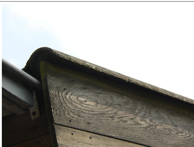
Ruime overstek golfplaten bij showroom.
