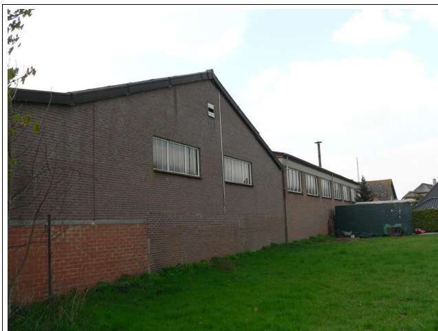
Opslagloods en werkplaats (oostzijde)
