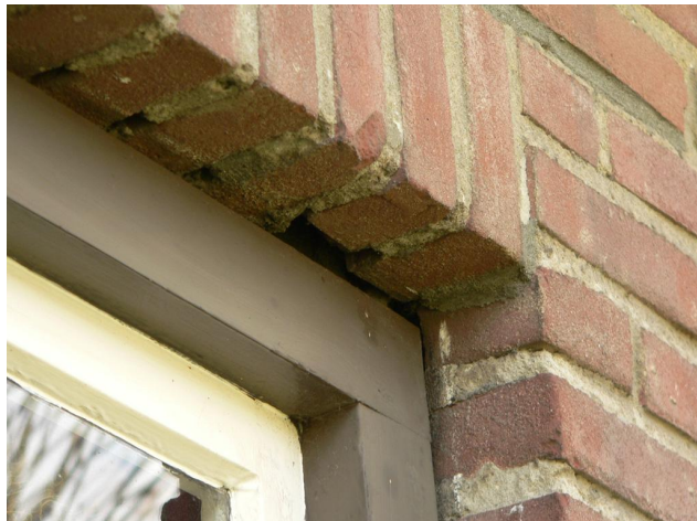
Toegang tot spouwmuur van woonhuis.
