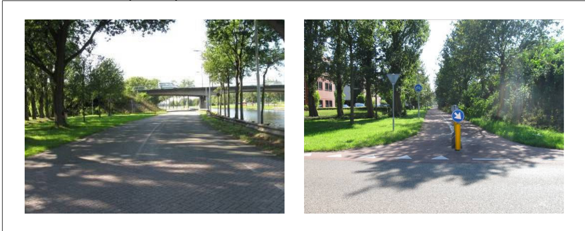
Afbeelding 3.10. Wilhelminakanaal Zuid (links) en tweerichtingenfietspad (rechts)
