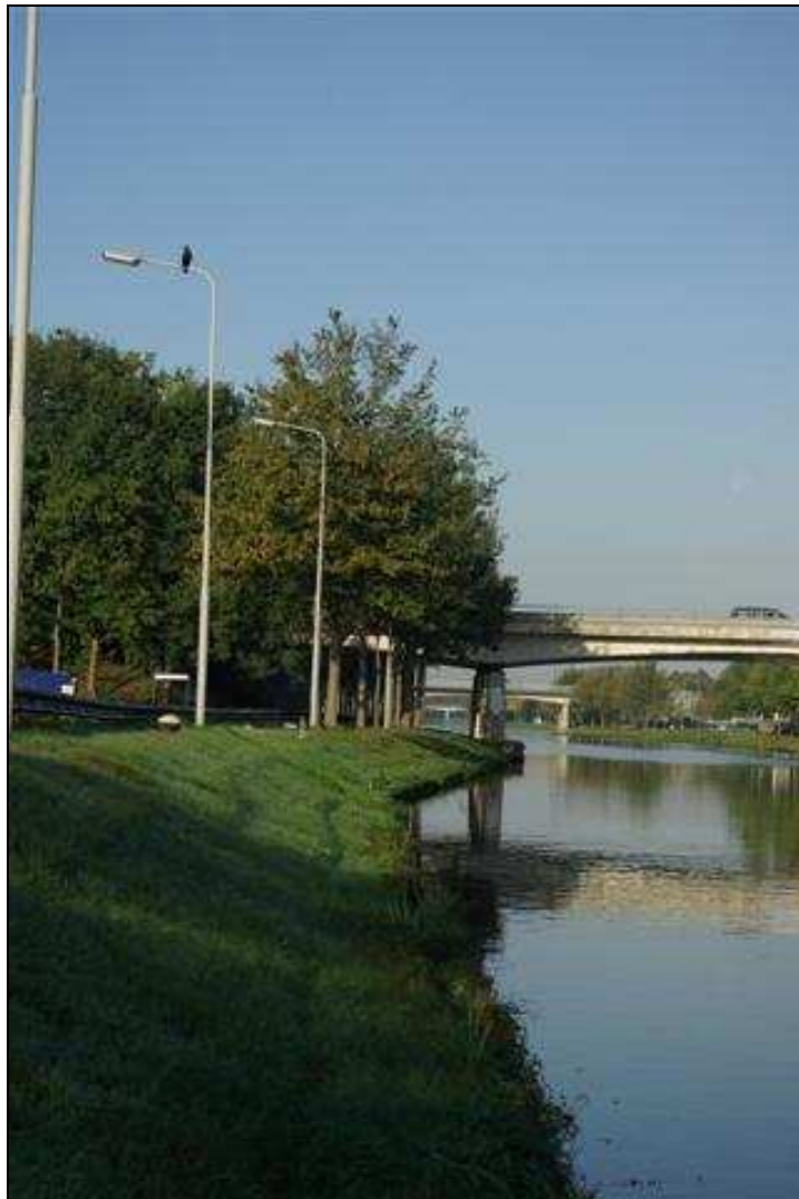
Afbeelding 3.1. Kanaaloever ter hoogte van Döhler
