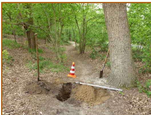
Afbeelding 30: overzichtsfoto profielkuil 13, ter hoogte van boom 284
