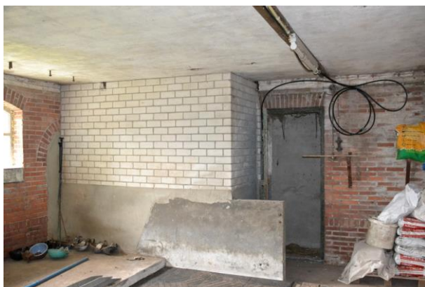
Dichtgezette openingen (links: naar buiten; rechts: naar het tussenlid) in de stal aan de westzijde van de schuur.
