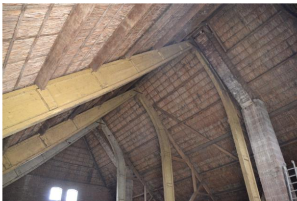
Interieur van de schuur met asymmetrische kniespanten.
