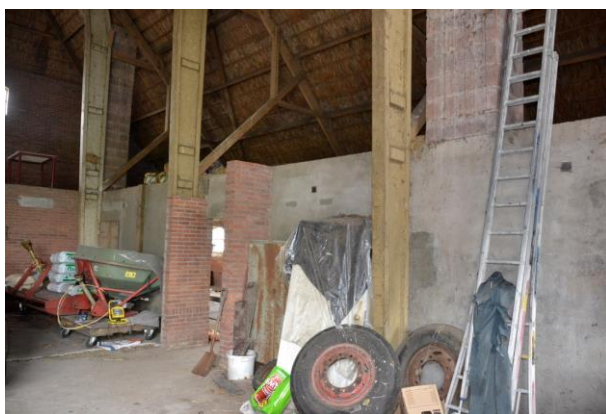
Scheidingsmuur tussen de deel en de stal aan de westzijde.
