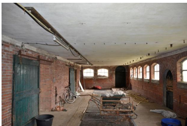
Interieur van de stal aan de westzijde van de schuur.
