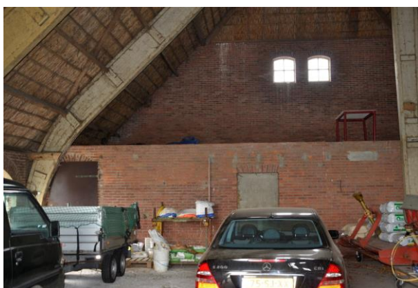
Scheidingsmuur tussen de deel en de stal aan de zuidzijde.
