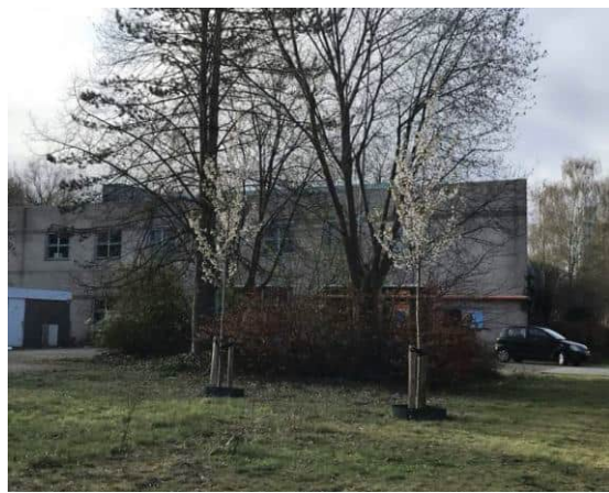
Afbeelding 7. Zicht op de noordgevel van het kantoorgebouw, gezien vanaf de grasstrook
