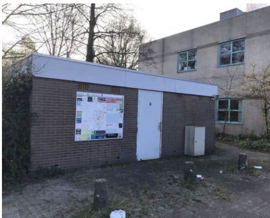
Afbeelding 6. Klein bakstenen gebouwtje op de parkeerplaats, ten westen van het kantoorgebouw
