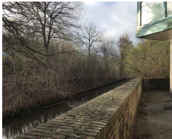
Afbeelding 5. Achtergevel (oostzijde) van het kantoorgebouw, grenzend aan het vaartje
