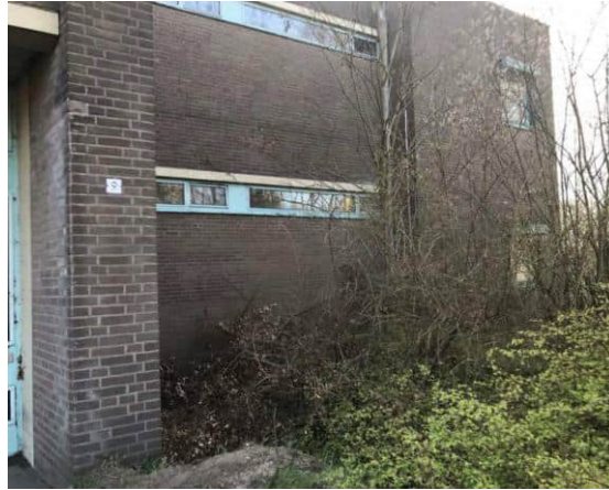
Afbeelding 3. Rechter voorzijde (westzijde) van het kantoorgebouw
