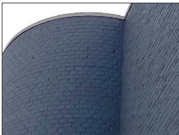
Foto A: Abdis van Thornstraat 70b (metalen dakrand en open stootvoegen)
