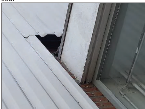
Foto C: Oostelijke gevel Abdis van Thornstraat 68a
