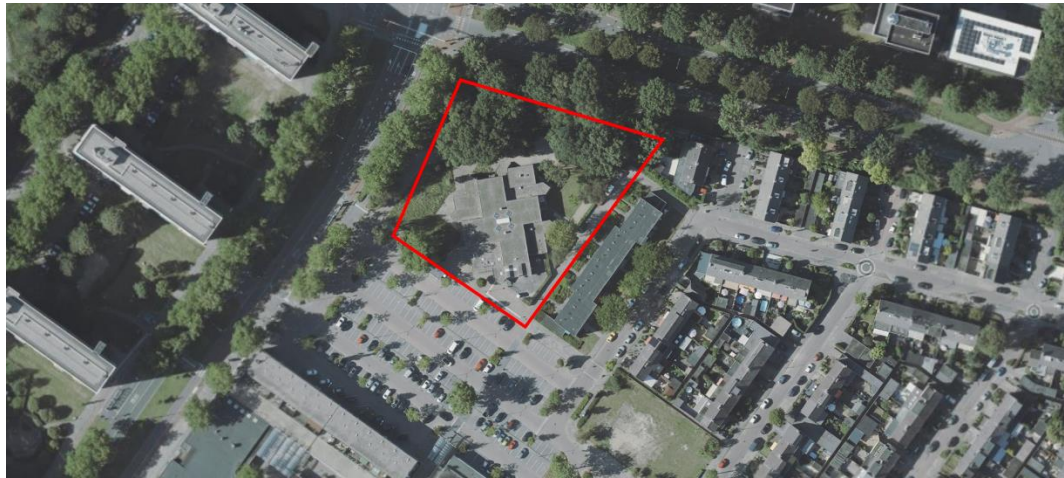
Figuur 2.2 Luchtfoto huidige inrichting, plangebied is aangegeven met rode kader (bron: Luchtfoto NL 2020 © CycloMedia Technologie B.V.)
