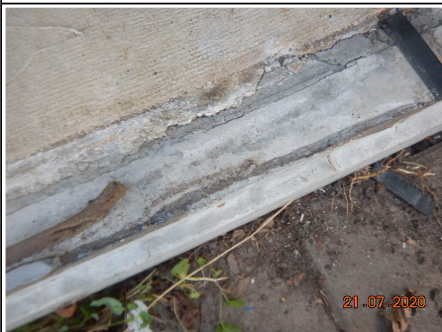
Foto 9. Asbestverdachte kit monster naar RPS voor analyse.
