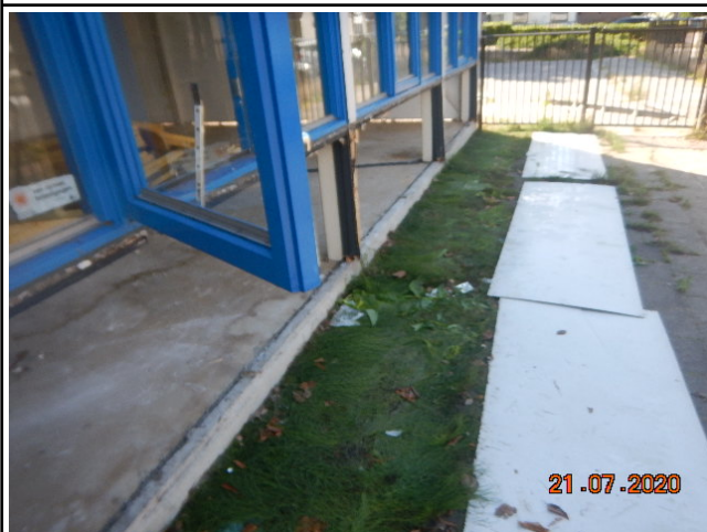
Foto 8. Inspectie onder de platen.
