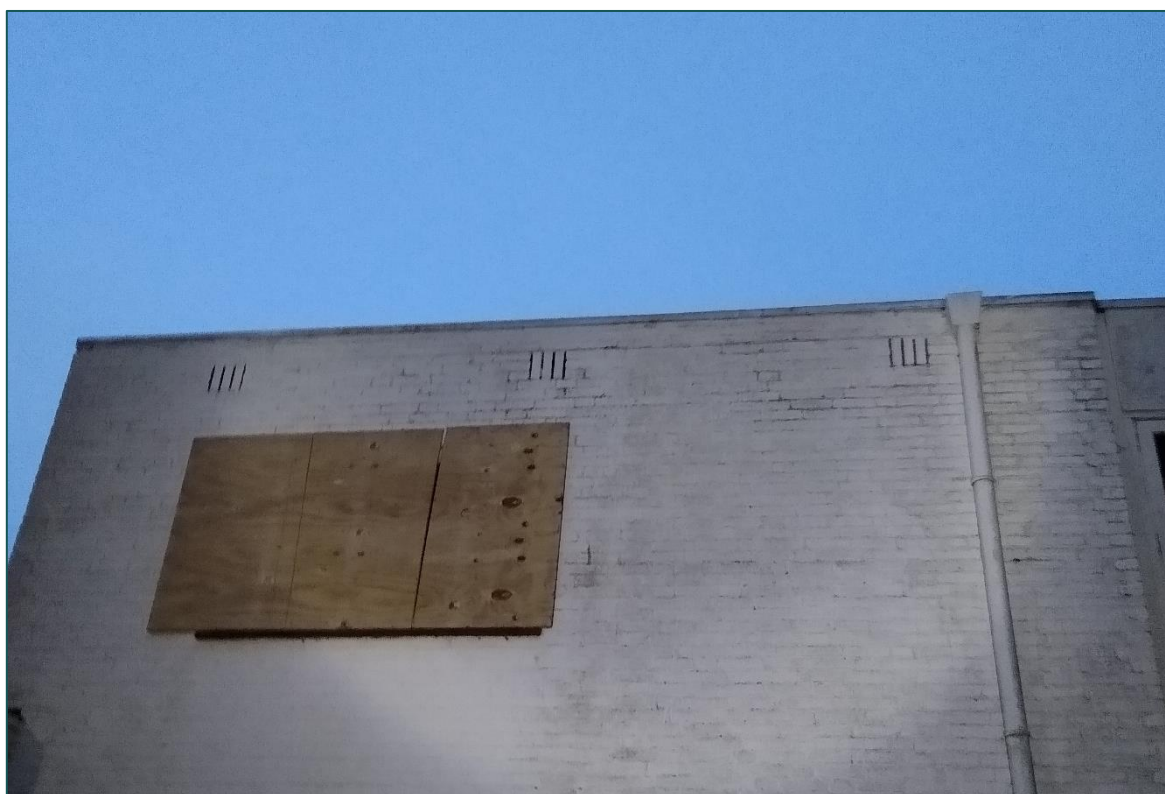
Figuur 3.3 Visuele weergave van de gebruikte opening c.q. ventilatievoegen van de zomerverblijfplaats aan de Keiweg 74 te Oosterhout.
