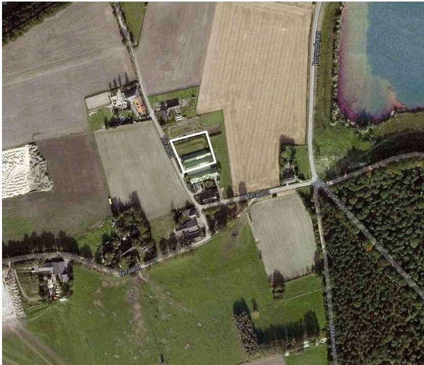
Luchtfoto oude situatie met de agrarische bedrijfsbebouwing
