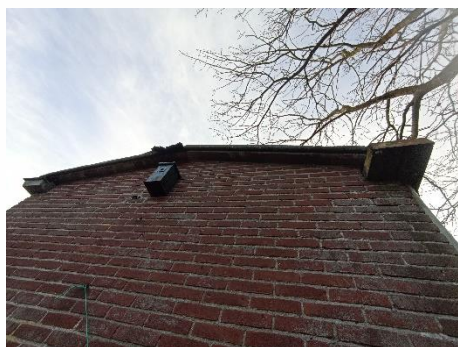
Figuur 4.4.1. Tussen het dak en de gevel zijn geen openingen aanwezig.
