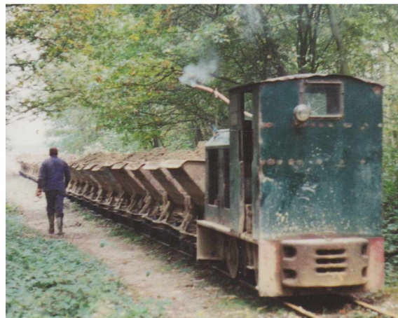
Smalspoorlijn leemwinning van de Steenfabriek Dorst.
