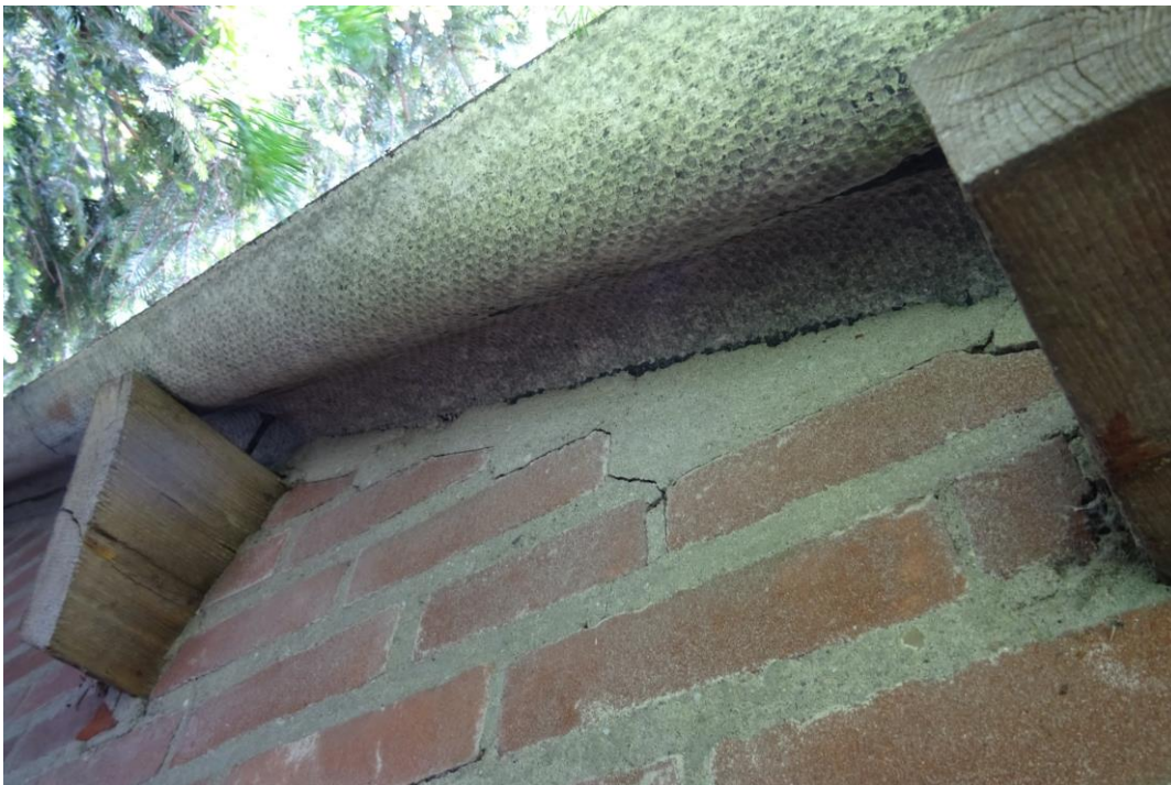
Afbeelding 5: Openingen tussen muur en golfplaten afgedicht met specie. Bron: Rik Bijvelds, 14-05-2020
