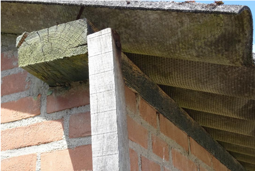
Afbeelding 4: Spouwmuur van bovenzijde afgesloten door balk van de dakconstructie. Bron: Rik Bijvelds, 14-05-2020
