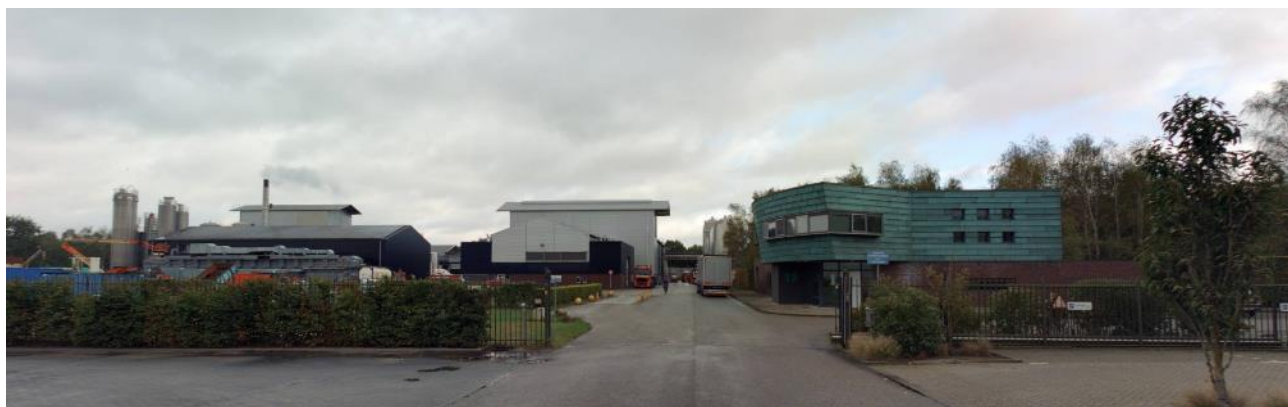
Figuur: Entree bestaande bedrijf Rodenburg
