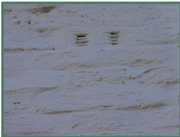
Stootvoeg afgesloten met bijenbekje
