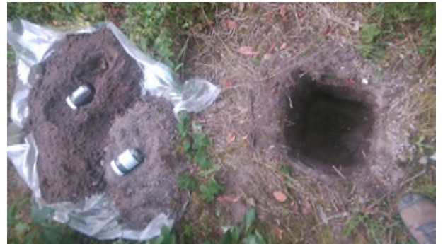
Fotonummer: 10 Omschrijving: Asbestgat 011
