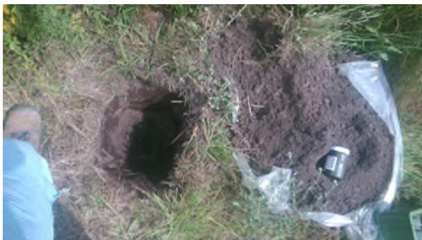
Fotonummer: 11 Omschrijving: Asbestgat 012
