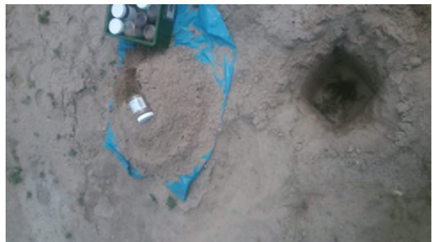
Fotonummer: 6 Omschrijving: Asbestgat 006
