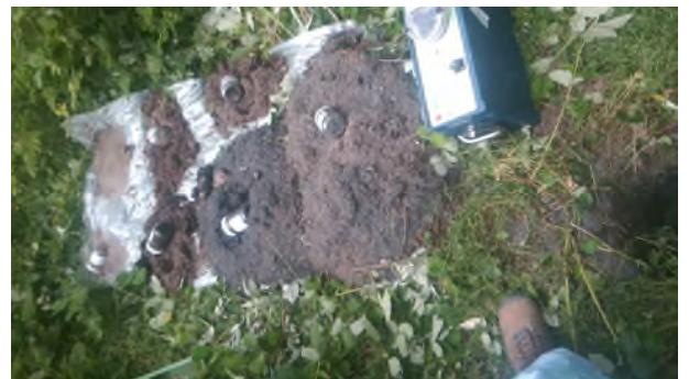
Fotonummer: 12 Omschrijving: Asbestgat 013
