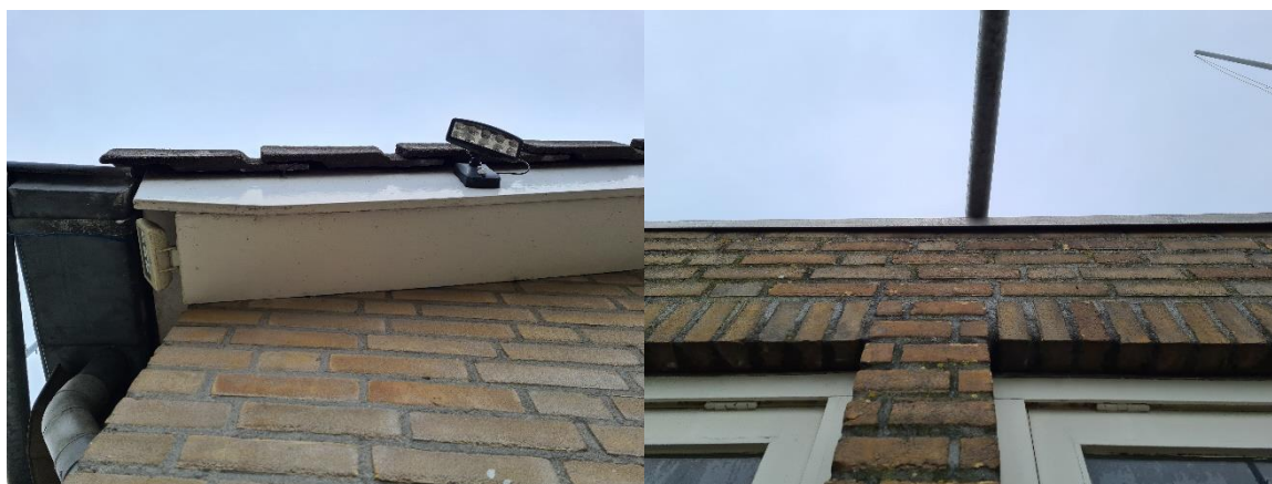
Afbeelding 5.6 Mogelijk vleermuisgeschikte ruimtes onder kantpannen en dakrand van het clubgebouw van V.V. Irene'58
