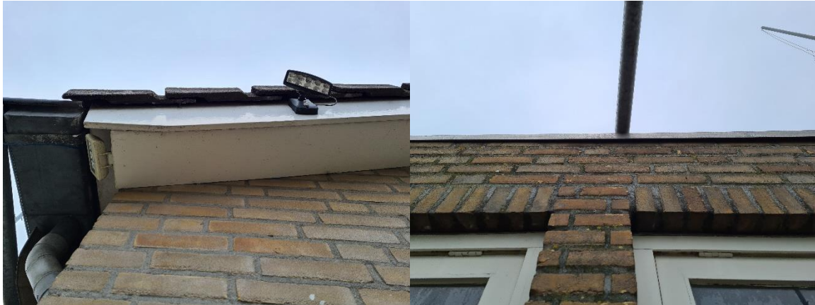
Afbeelding 5.6 Mogelijk vleermuisgeschikte ruimtes onder kantpannen en dakrand van het clubgebouw van V.V. Irene'58
