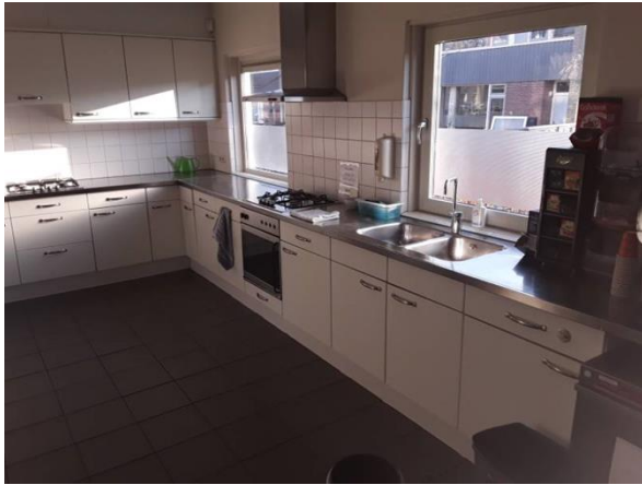
FB05: Achter de wandtegels en vloertegels van de keuken heeft geen destructief onderzoek plaatsgevonden.
