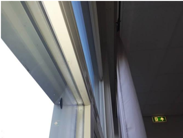
FB06: Het pand aan de Sweelinckstraat 10 is rondom voorzien van kunststof kozijnen waarbij het glas een datumstempel heeft uit 2003.
