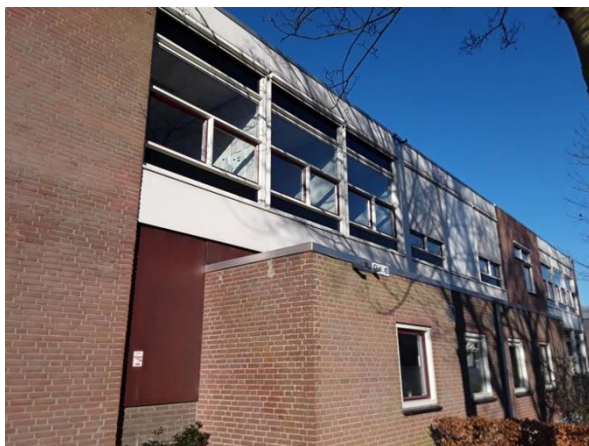
FB11: Achter gevelpanelen heeft geen onderzoek plaatsgevonden, de witte borstweringen zijn uitgevoerd in beton, de boeiboorden zijn in verband met de hoogte niet onderzocht.
