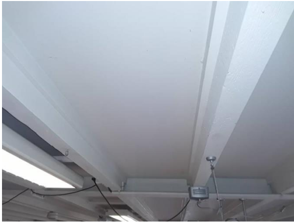
FB09: Het plafond in de winkel is uitgevoerd in gipsplaten.
