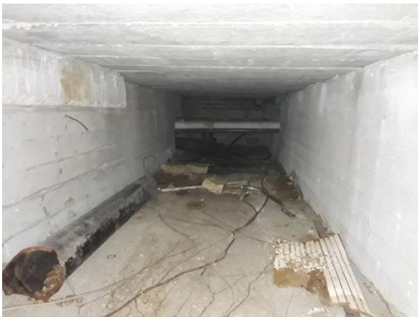
FB07: De kruipruimte valt buiten de scope van het onderzoek. Om informatieve redenen is wel vanuit het vloerluik een visuele inspectie uitgevoerd. Bij werkzaamheden in de kruipruimte dient deze aanvullend onderzocht te worden.
