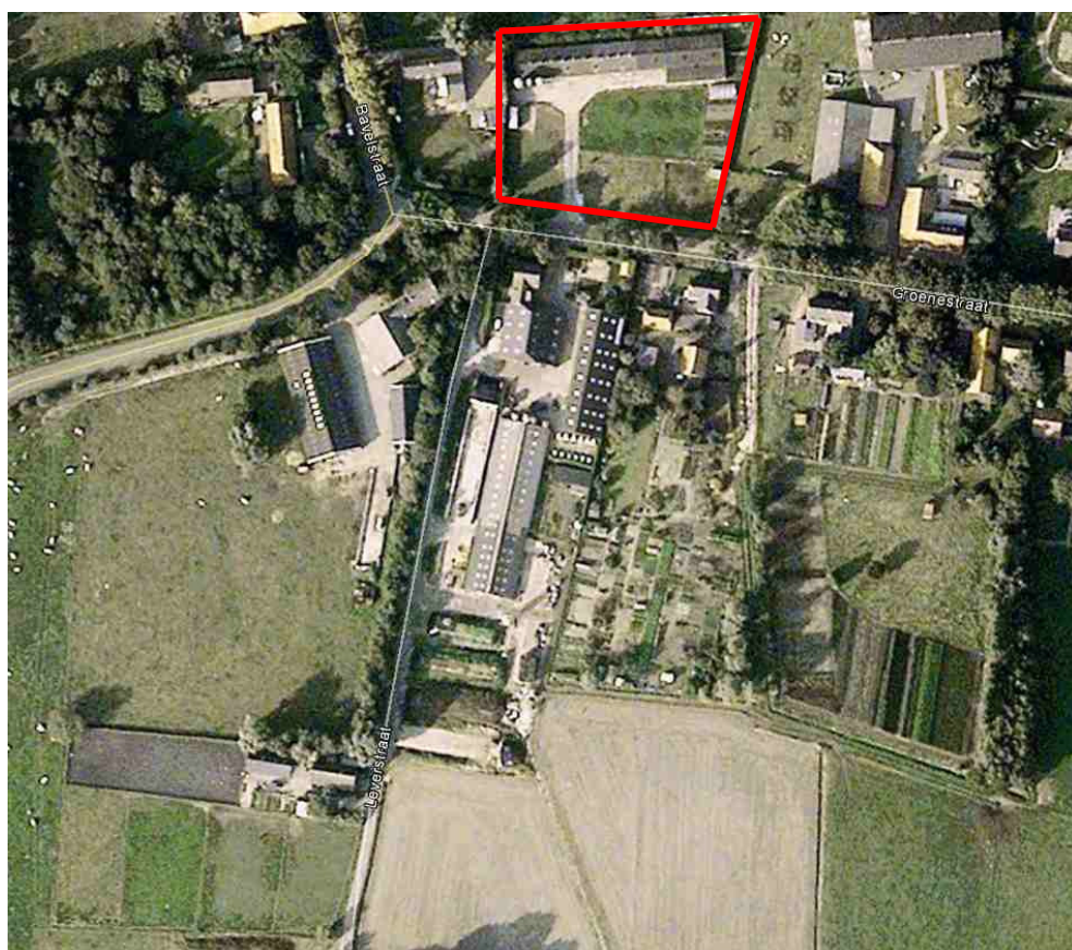
Afbeelding 6: bestaande situatie in en rondom het plangebied - de langwerpige stal binnen het plangebied zal worden gesloopt.
