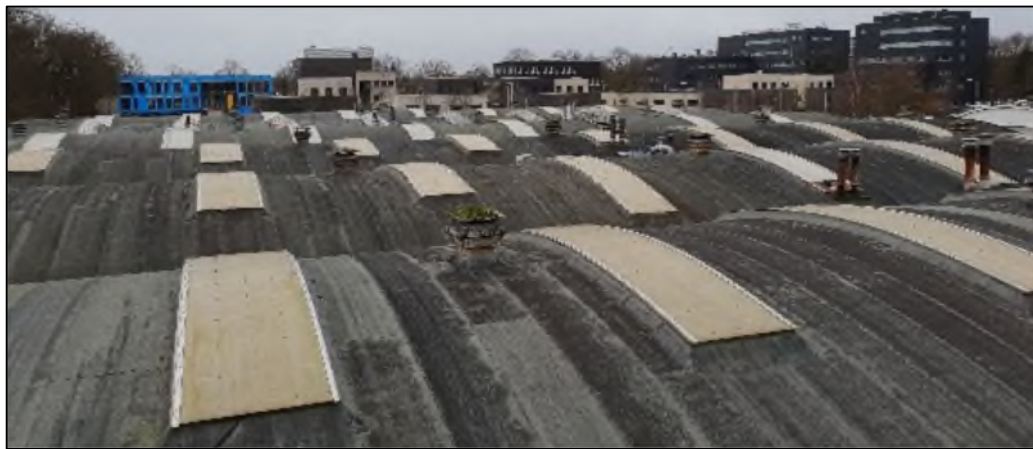
Figuur 4.3. Bovenaanzicht van de daken van de bedrijfshallen in het plangebied.
