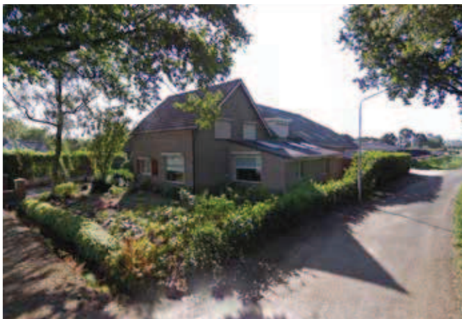
Bestaande woning Groenestraat 2 - hoek Leverstraat
