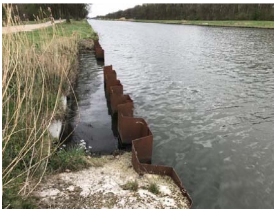
Referentiebeeld smalle faunauittreedplaats met damwandprofielen
