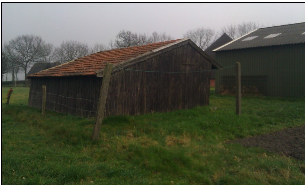
Afbeelding 4.2 Te slopen bedrijfsgebouwtje
