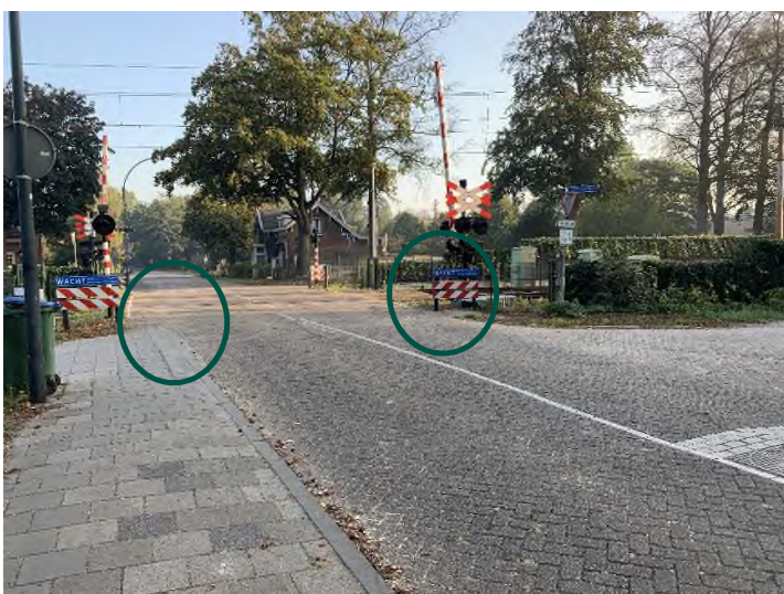
Figuur 12: Huidige spoorwegovergang op de Wethouder van Dijklaan (voetgangers maken gebruik van gedeelde ruimte met overig verkeer)
