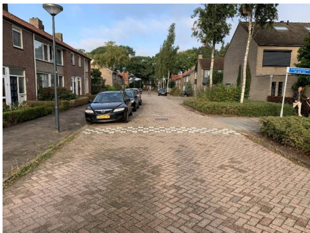
Figuur 10 – In de Cypresenstraat is slechts een verkeersdrempel aanwezig
