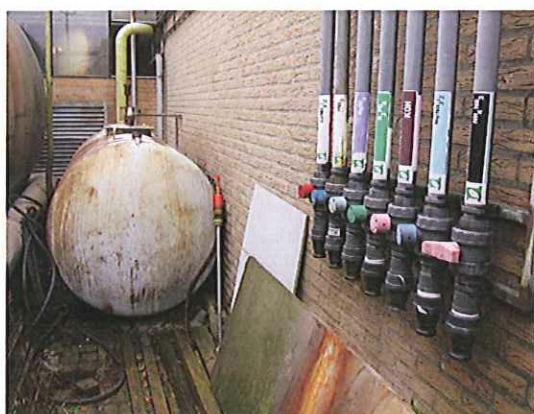
Foto 3: Baarschotsestraat 23 ter plaatse van zuren aftappunt en bovengrondse (gas)tank
