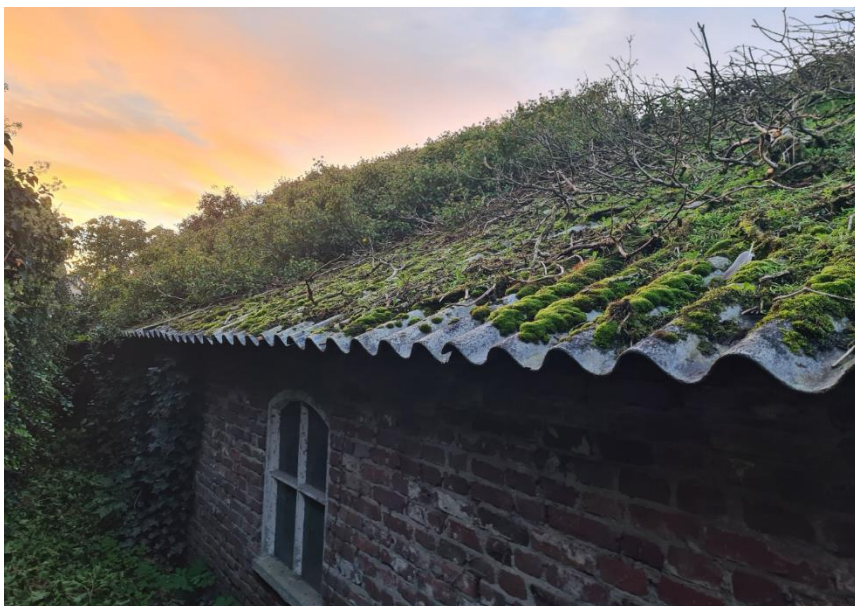
Figuur 5: Noordzijde schuur
