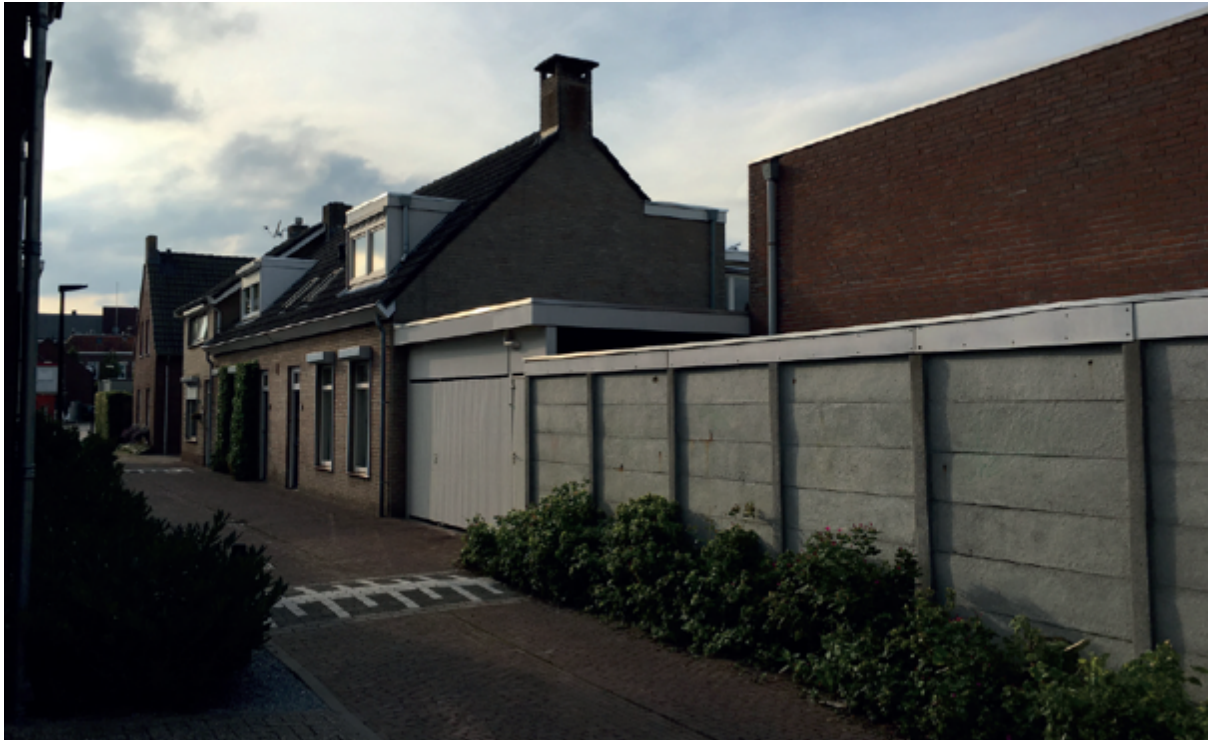
Foto voormalige loods; bron: Aerde Borgert Architecten
