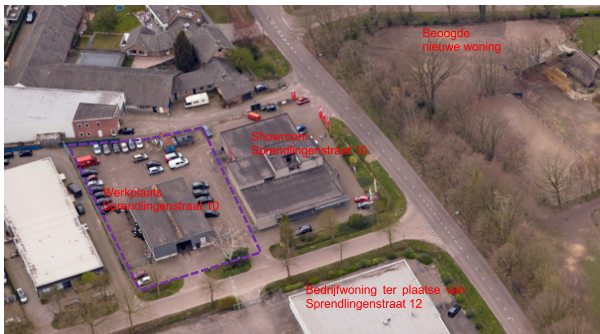
Recente luchtfoto van het perceel met cijfer 3 met in paars de werkplaats
