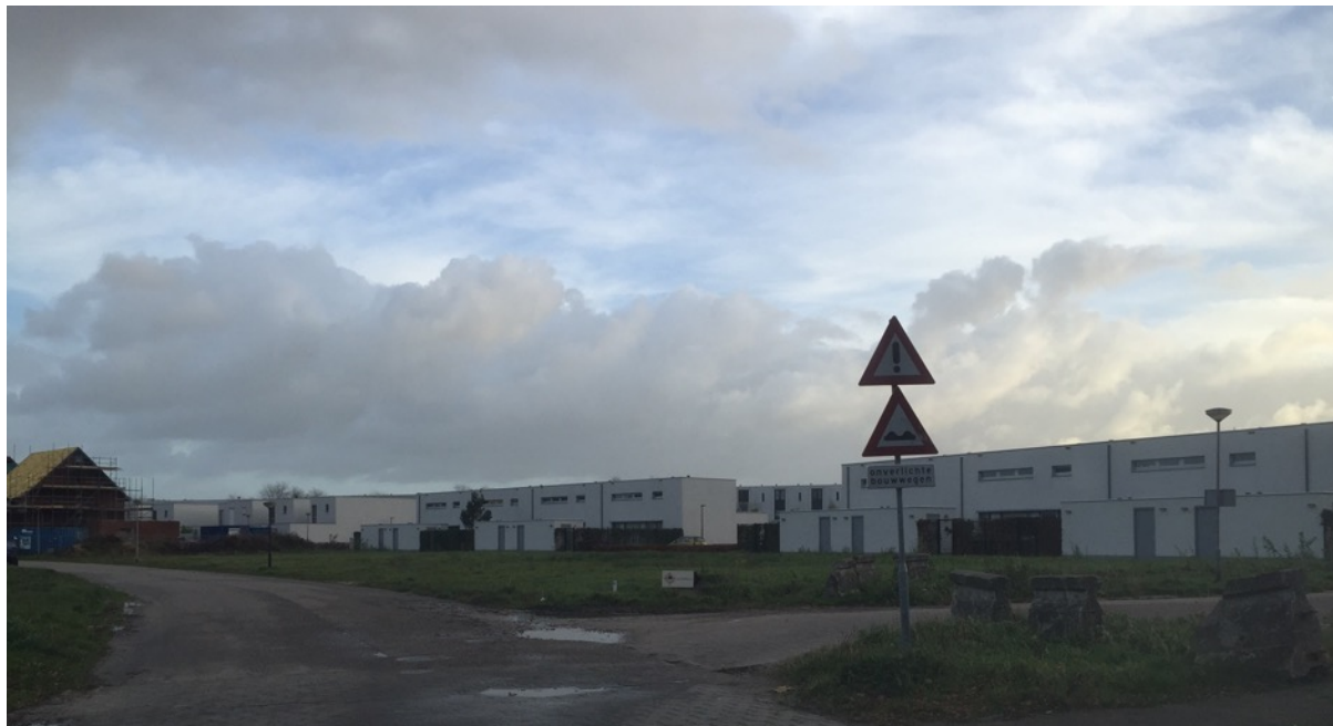
Figuur 4: Foto braakliggend perceel met de aanbouw van Pannenschuur Buiten
