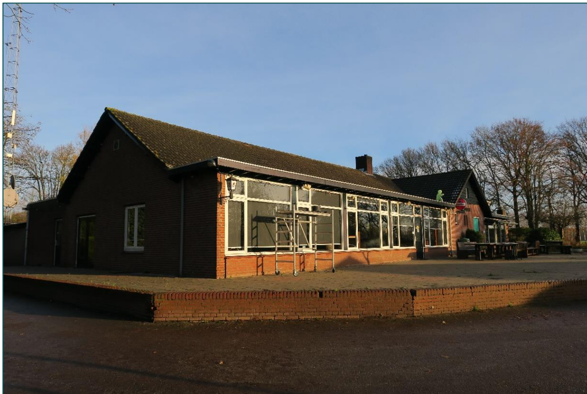
Figuur 4 Eén van de te slopen restaurants.
