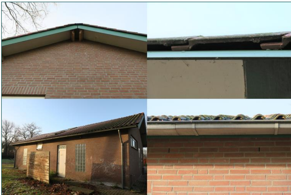
Figuur 1 Potentie voor vleermuizen onder de kantpannen en stootvoegen bij één van de sanitair gebouwen.
