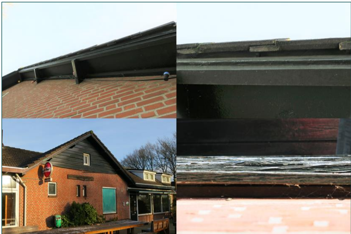
Figuur 3 Potentie voor vleermuizen onder de kantpannen en houten gevelbekleding bij één van de restaurants.
