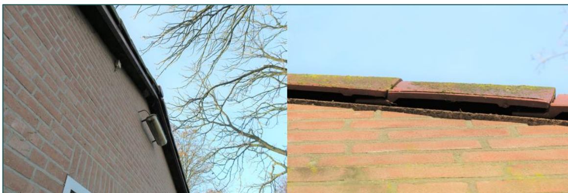
Figuur 2 Potentie voor vleermuizen onder de kantpannen en stootvoegen bij één van de sanitair gebouwen.
