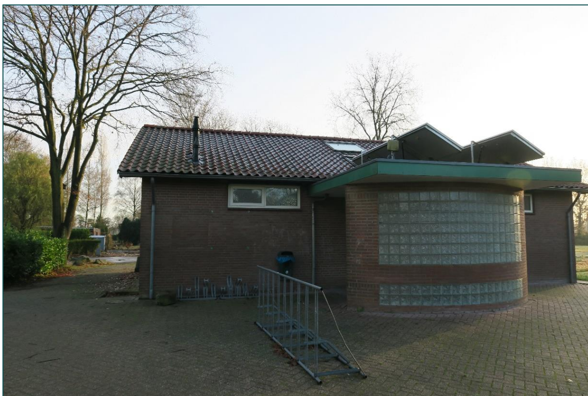
Figuur 2 Eén van de te slopen sanitair gebouwen.
