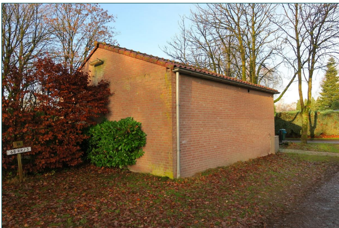
Figuur 3 Eén van de te slopen sanitair gebouwen.
