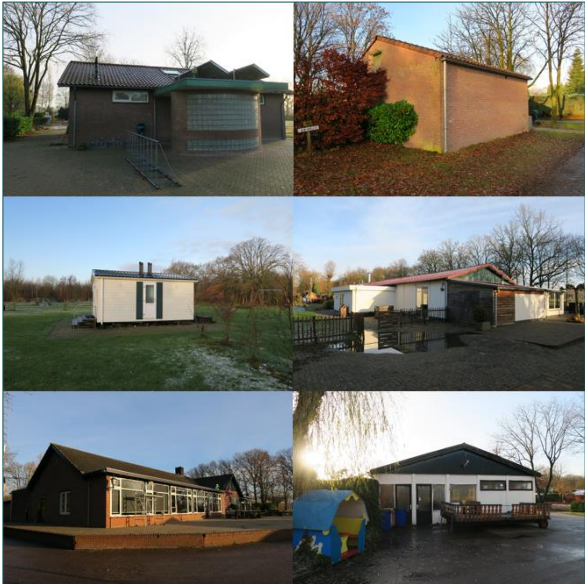
Figuur 1.3 Fotografische indruk van de planlocatie. Boven en midden links de te slopen sanitair gebouwen. In het midden rechts en onder zijn de restaurant met naastgelegen gebouw weergegeven.
