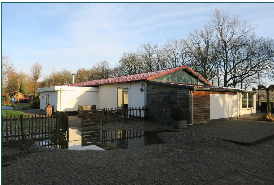
Figuur 6 Eén van de te slopen restaurants.
