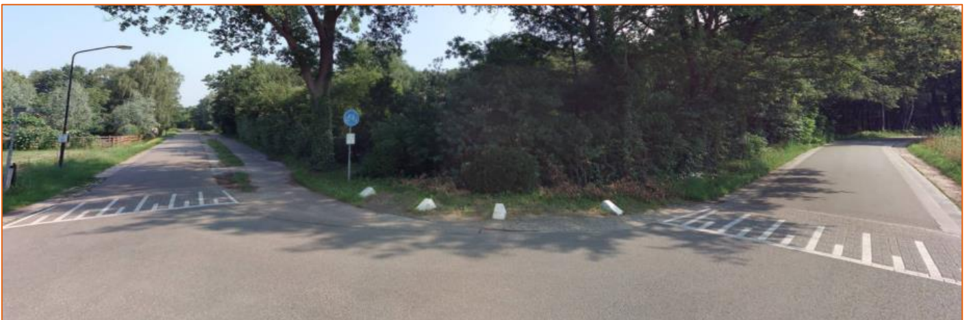
Figuur 7: Kruispunt Fransebaan – Zandstraat (Bron: Cyclomedia)
